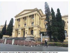
As paredes amareladas do Museu Paulista resoberto a cor original, obra resuado
