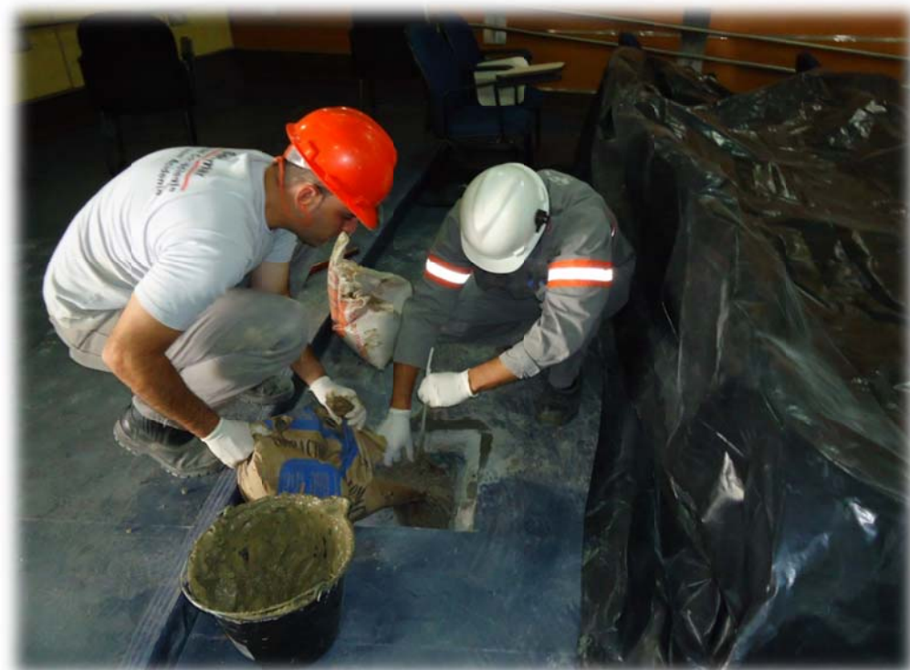
Foto 14 – Preenchimento com bentonita granulada acima do pré-filtro colocado no PMG - nível A.
