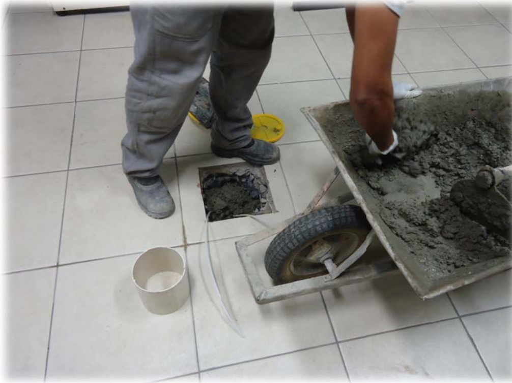
Foto 17 – Preenchimento com cimento para acabamento final.
