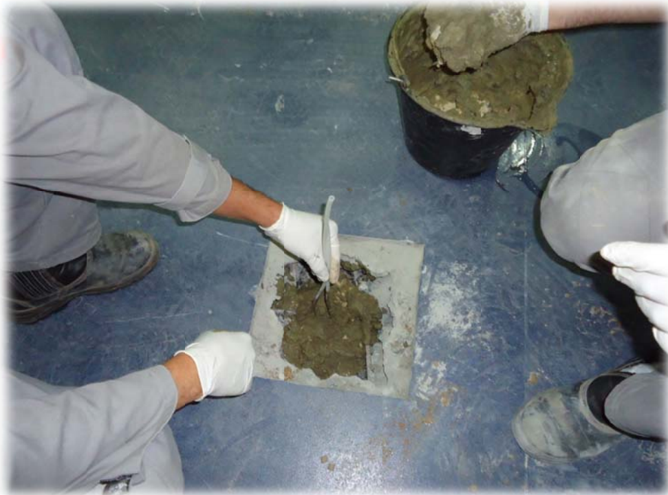
Foto 15 – Preenchimento com calda viscosa de bentonita até aproximadamente 0,15 m de profundidade.
