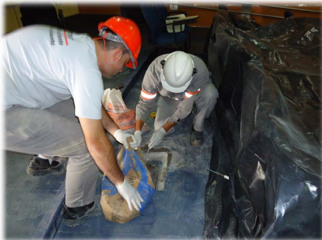
Foto 10 – Preenchimento de 0,05 m de bentonita granulada, posicionada acima da camada de pré-filtro.
