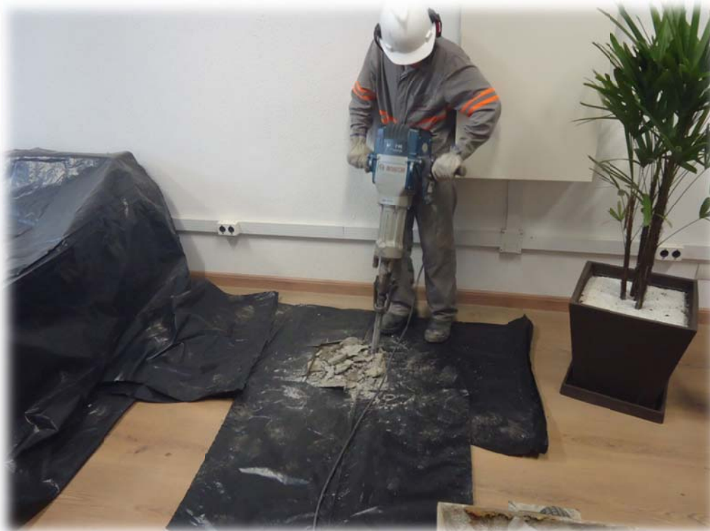
Foto 04 – Quebra de piso.
