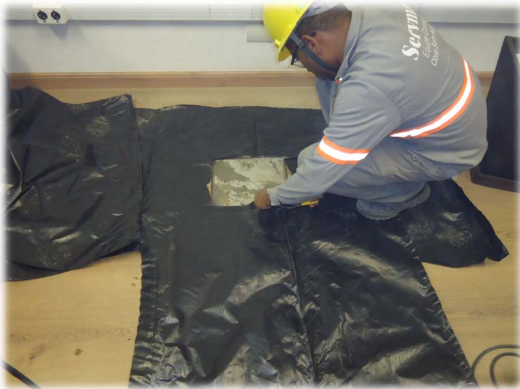
Foto 03 – Processo de quebra de piso para instalação dos poços de monitoramento de gases.
