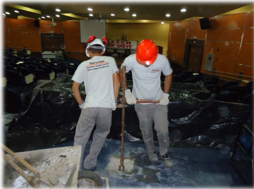
Foto 05 – Execução da sondagem a trado manual.
