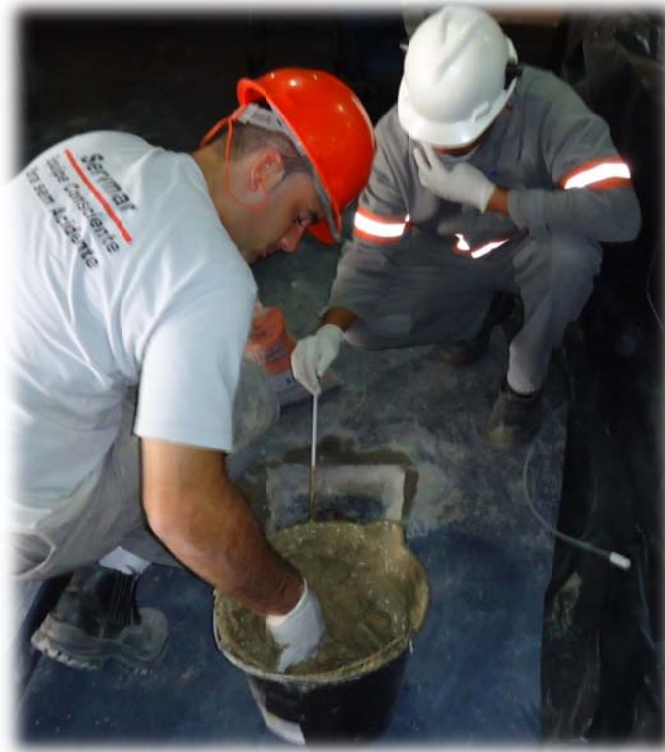
Foto 11 – Preenchimento com calda viscosa de bentonita até aproximadamente 0,4 m de profundidade.
