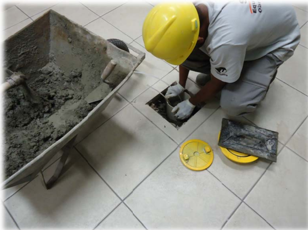
Foto 18 – Instalação final – Aplicação da câmara de calçada.
