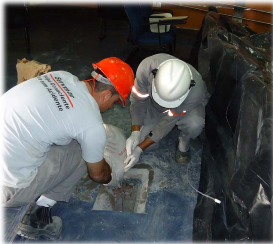
Foto 09 – Momento em que o pré-filtro foi preenchido na pedra porosa do PMG instalado no nível B (aproximadamente 1,0m de profundidade).
