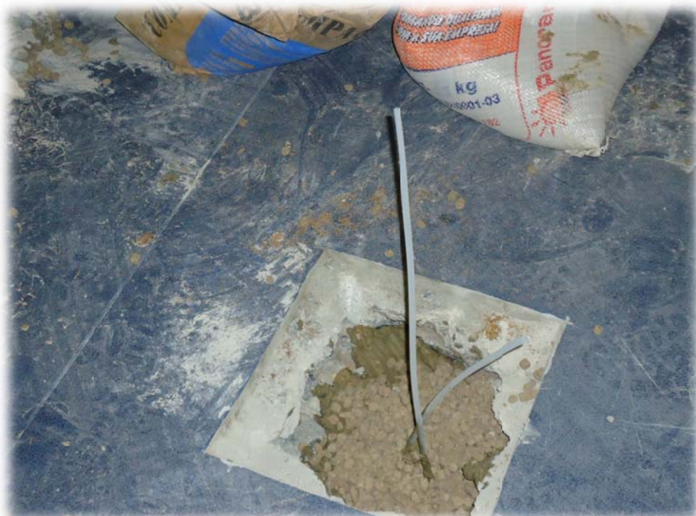
Foto 16 – Colocação de bentonita em pallet para acabamento final do PMG.
