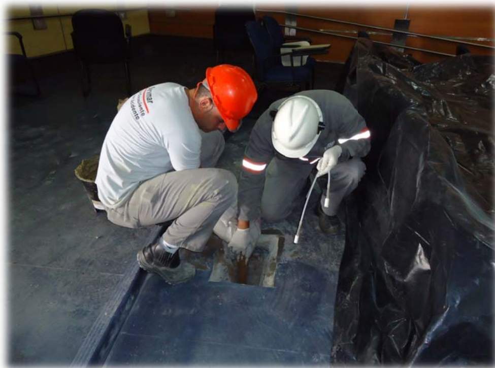
Foto 08 – Momento em que a cama de pré-filtro foi assentada no fundo da sondagem.
