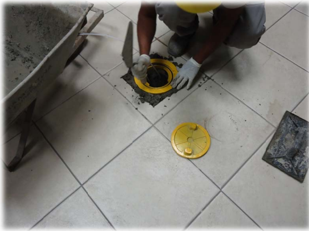
Foto 19 - Instalação final – Aplicação da câmara de calçada.
