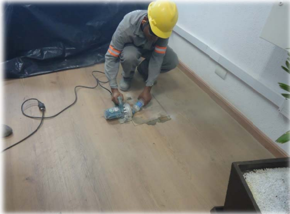
Foto 01 – Processo de quebra de piso para instalação dos poços de monitoramento de gases.
