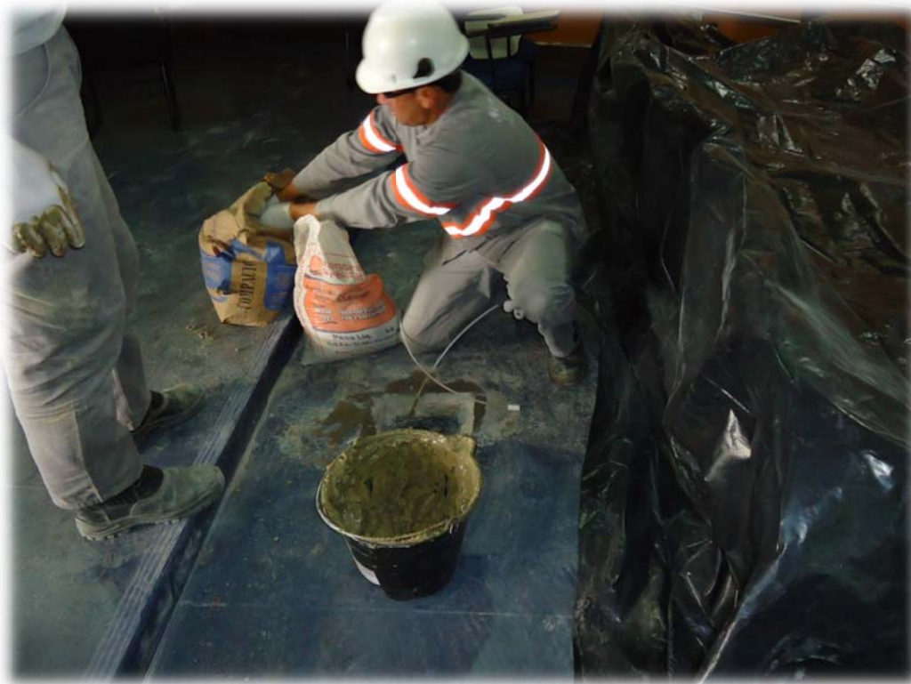
Foto 11 – Preenchimento com calda viscosa de bentonita até aproximadamente 0,4 m de profundidade.
