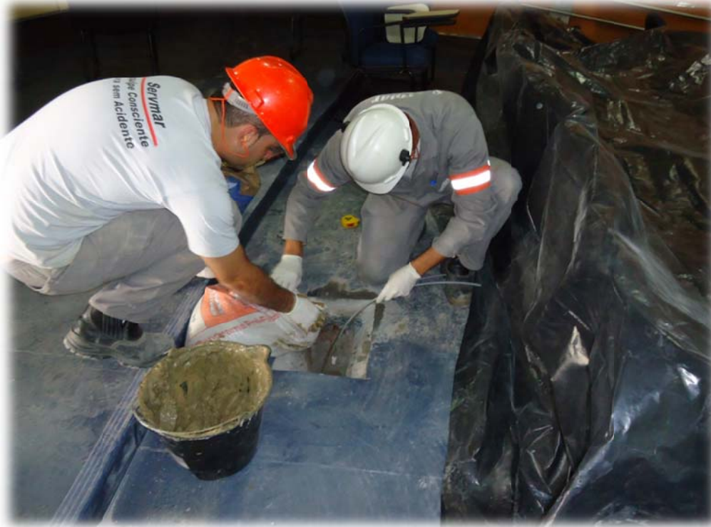
Foto 13 – Preenchimento da pedra porosa com pré-filtro na instalação do PMG - nível A.
