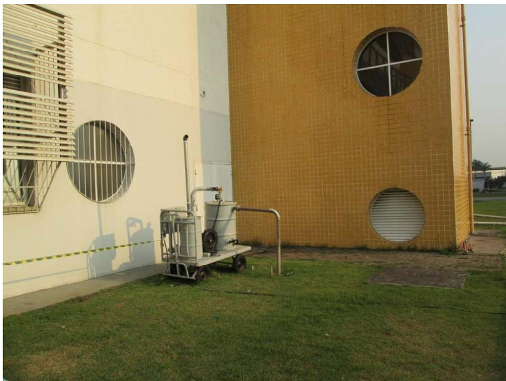
Foto 4.2.3 Exaustor conectado aos drenos – Bloco A3
