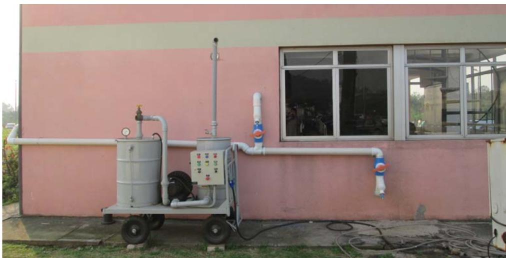
**Foto 4.11.1 Tubulação de Extração conectada ao Exaustor – Guarda Universitária**
