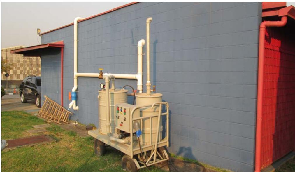
**Foto 4.12.1 Tubulação de Extração conectada ao Exaustor – Transportes**
