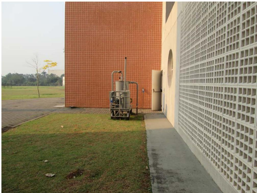
Foto 4.2.2 Exaustor conectado aos drenos – Bloco A2
