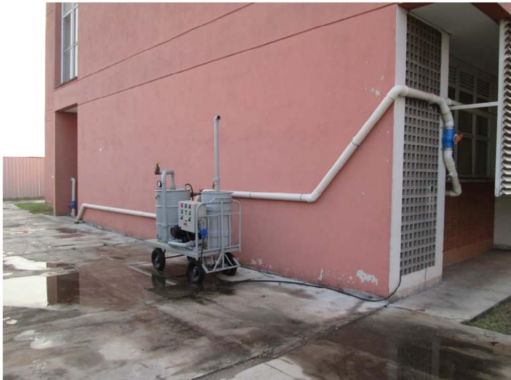
Foto 4.3.2 Tubulação de Extração e Exaustores – Módulo Inicial Bloco 1
