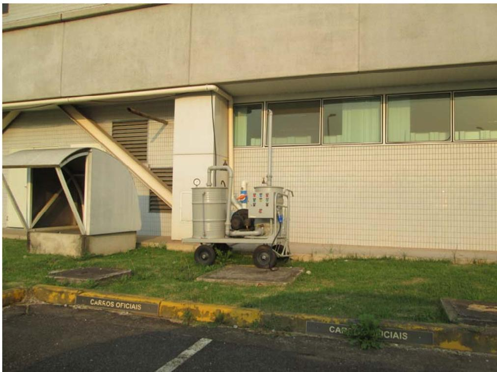
Foto 4.5.2 Tubulação de Extração aérea conectada ao Exaustor em abrigo – Edifício I-1 Estacionamento
