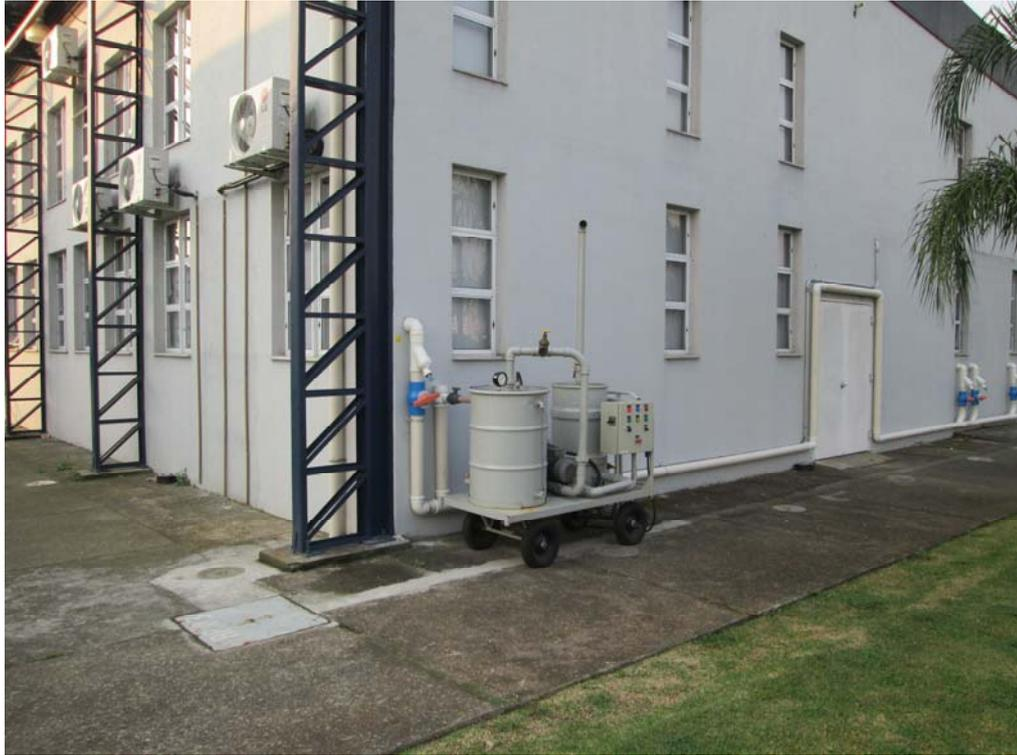
Foto 4.9.1 Tubulação de Extração conectada ao Exaustor – CAT-1
