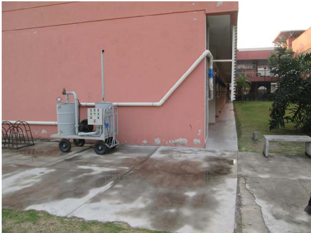
Foto 4.3.3 Tubulação de Extração e Exaustores – Módulo Inicial Bloco 2
