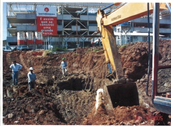
**Foto 3** – Exposição de material heterogêneo, com material bege pouco avermelhado na porção superior e um pouco mais escuro na parte inferior da parte mostrada na imagem. O material remobilizado contém volumes que parecem fragmentos de concreto, e não de rochas naturais. O barranco exposto pela retirada de material parece ter granulometria predominantemente fina, com teor importante de argila, pelas marcas lisas deixadas pela escavadeira.
