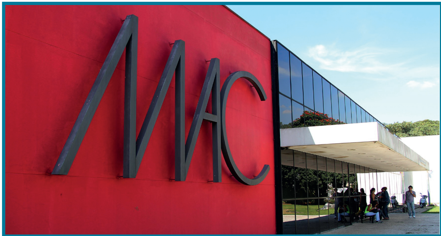
Foto 1 - Fachada do prédio do Museu de Arte Contemporânea da Universidade de São Paulo.
