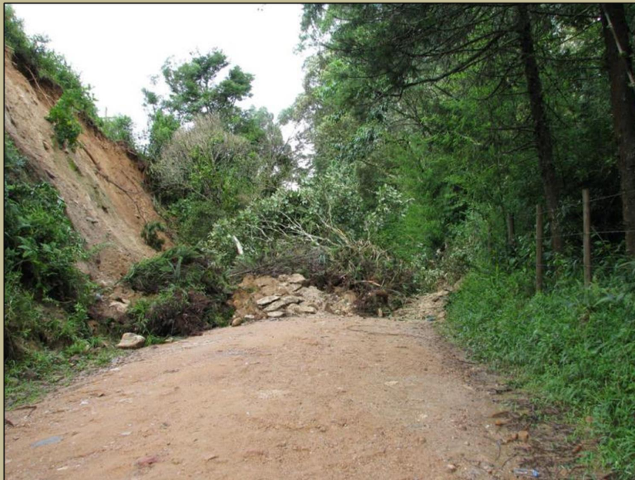
Figura 45. Deslizamento de terra em decorrência dos eventos de 01/01/2010
