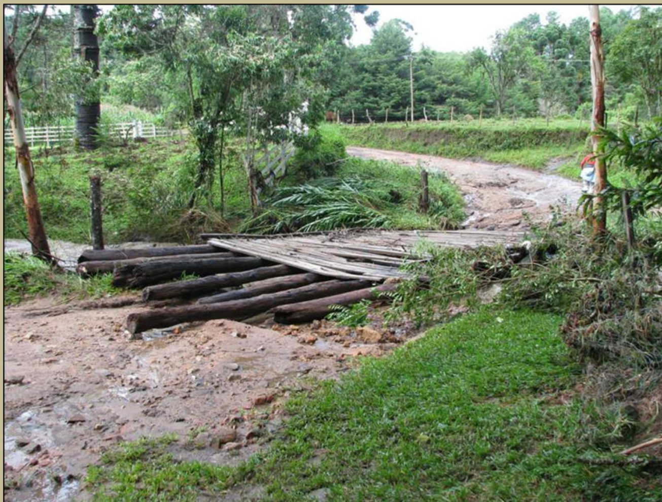
Figura 46. Ponte atingida pela enchente em decorrência dos eventos de 01/01/2010
