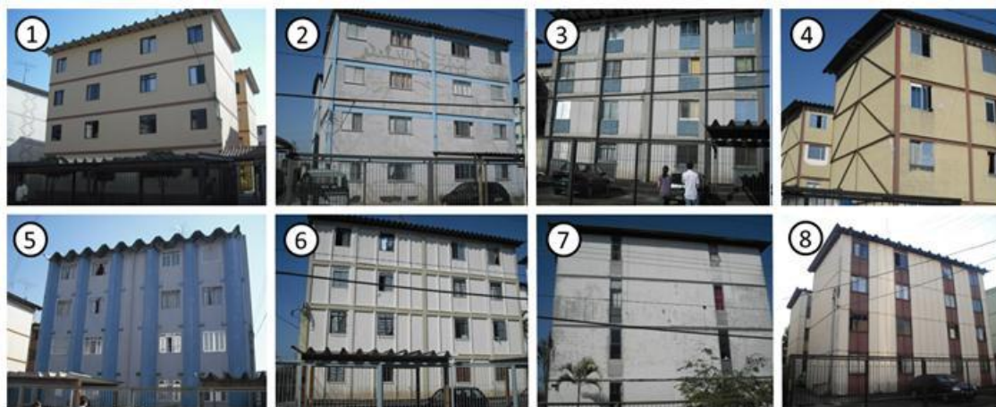
Figura 2 – Alguns dos sistemas construtivos produzidos no Canteiro Experimental Heliópolis (Silva et al. 2010).
