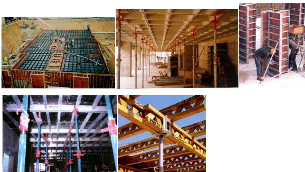
Figura 7 – Sistemas de fôrmas racionalizadas disponíveis no mercado nacional para produção de ERCA (fonte: arquivo Mercia Bottura de Barros)
