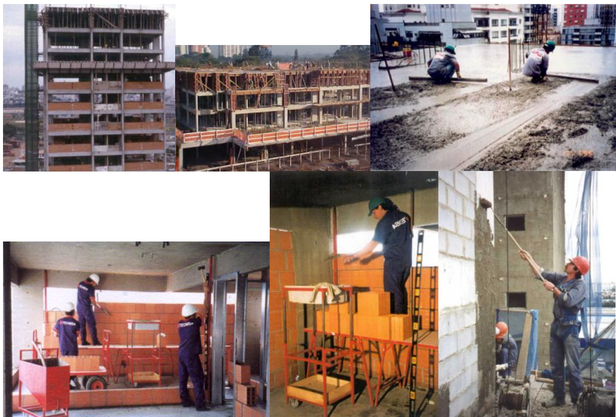
Figura 5 – Métodos construtivos racionalizado de produção de estrutura de concreto armado moldada no local, vedos de alvenaria de blocos de concreto e cerâmico e revestimentos de argamassa desenvolvidos e aplicados na construção nacional, a partir do início dos anos 1990 (Fonte: Arquivo Mercia Bottura Barros).
