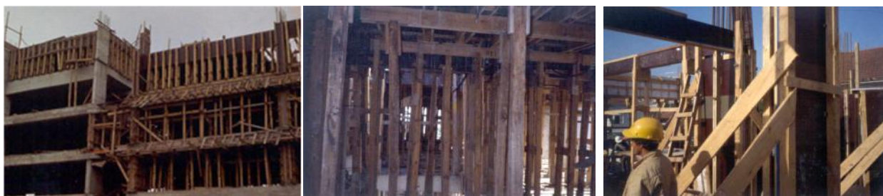
Figura 6 – Sistemas de fôrmas comumente utilizados em processos tradicionais de produção de ERCA (fonte: arquivo Mercia Bottura de Barros)
