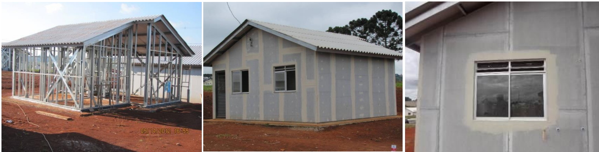
Figura 19 – Sistema Light steel framing para a produção de habitação para uso em casas térreas.
