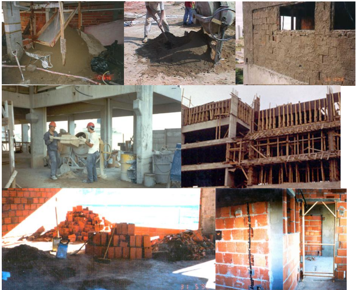
Figura 3 – Condições de produção ao longo do período pós-extinção do BNH (início da década de 1990) até fins do século 20: baixa produtividade, desperdícios de materiais, subjetividade nas decisões de produção, larga interferência entre os subsistemas (Fonte: Arquivo Mercia Bottura Barros).
