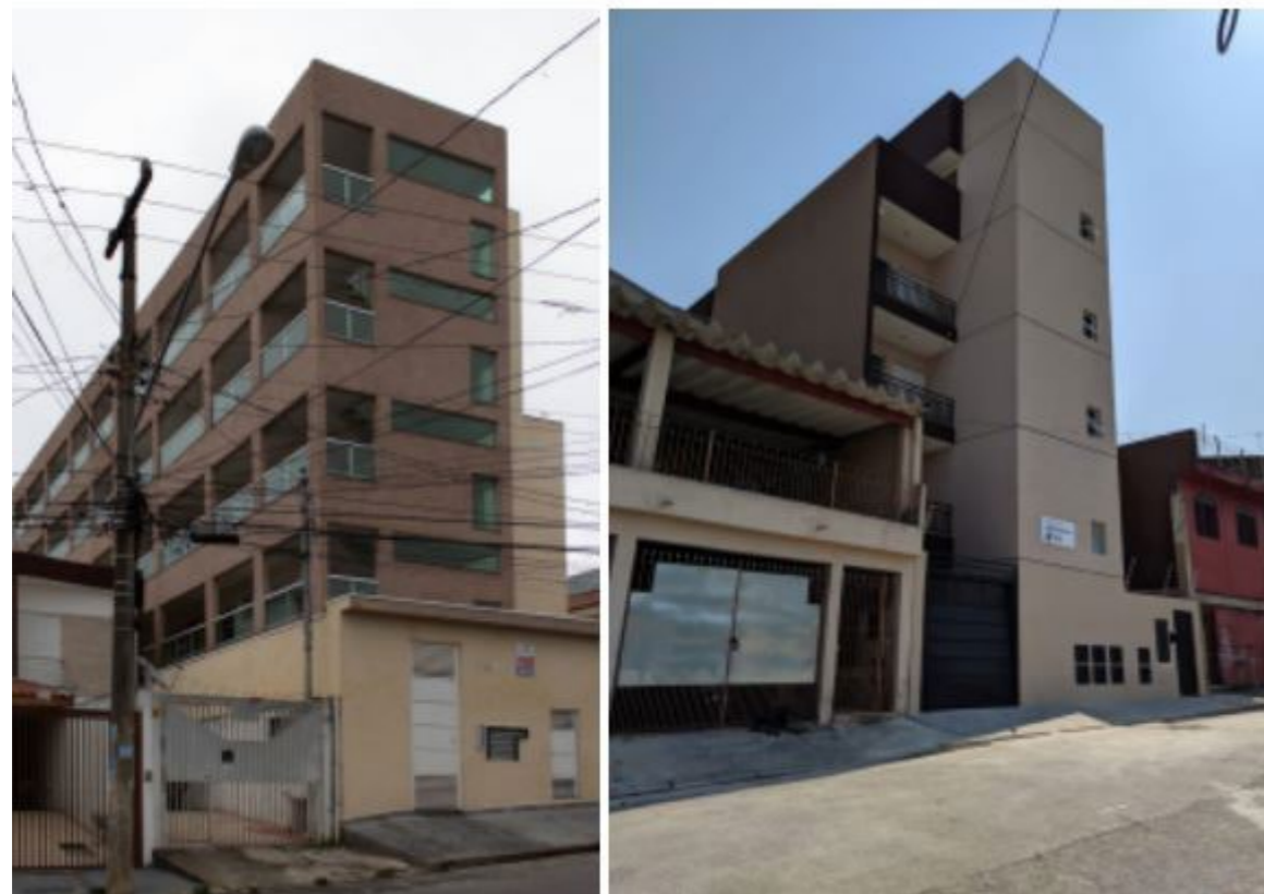
FIGURA 3 – EXEMPLOS DE EMPREENDIMENTOS DE NOVA TIPOLOGIA NA REGIÃO DE MIOLO DO BAIRRO DE ARTUR ALVIM, ZONA LESTE. ELABORAÇÃO: OS AUTORES.
