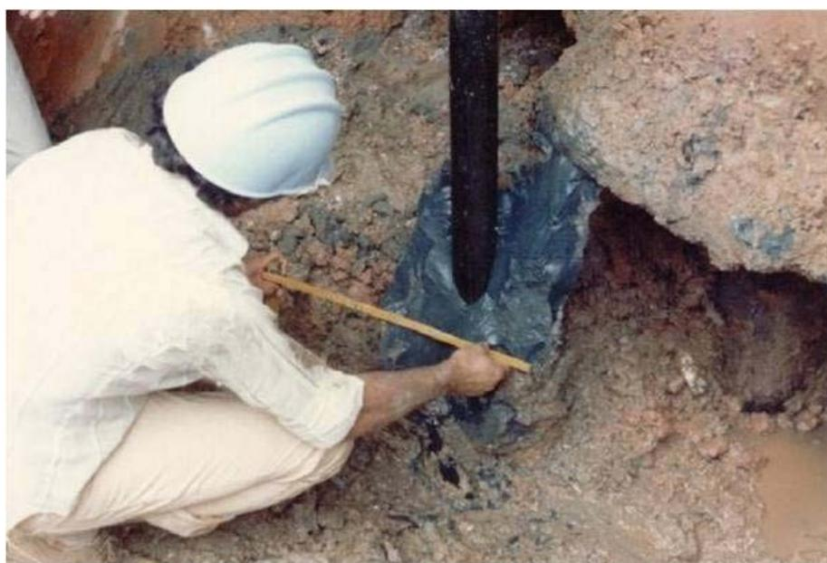
**Fotografia 15:** Detalhe da EIA para reforço de fundação.
