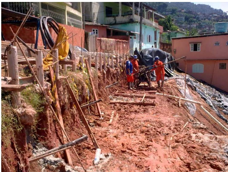
**Fotografia 6:** Estaca injetada autoperfurante associada a tirantes, executada com nove metros de comprimento, espaçadas a cada metro.
