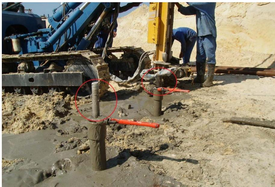
**Fotografia 10:** Detalhe da armadura complementar após execução da estaca.
