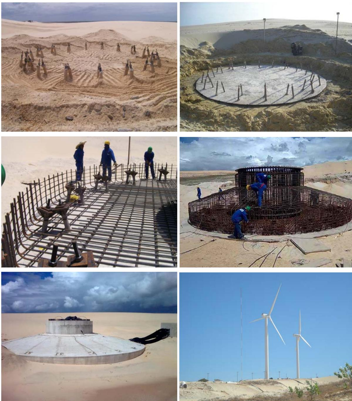
**Fotografia 20:** Sequencia executiva de implantação de Aerogeradores com estacas injetadas autoperfurantes com diâmetro nominal de 300 mm.
