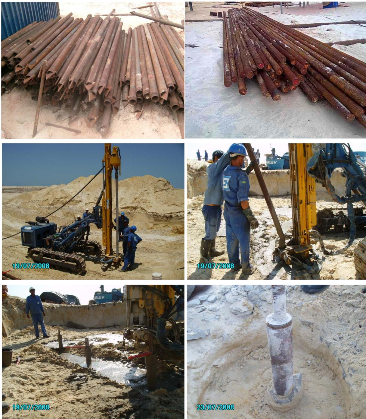
**Fotografia 7:** Sequencia executiva: (a) haste de perfuração, (b) armadura complementar, (c) perfuração, (d) haste de perfuração complementar, (e) colocação da armadura complementar, (f) estaca pronta.
