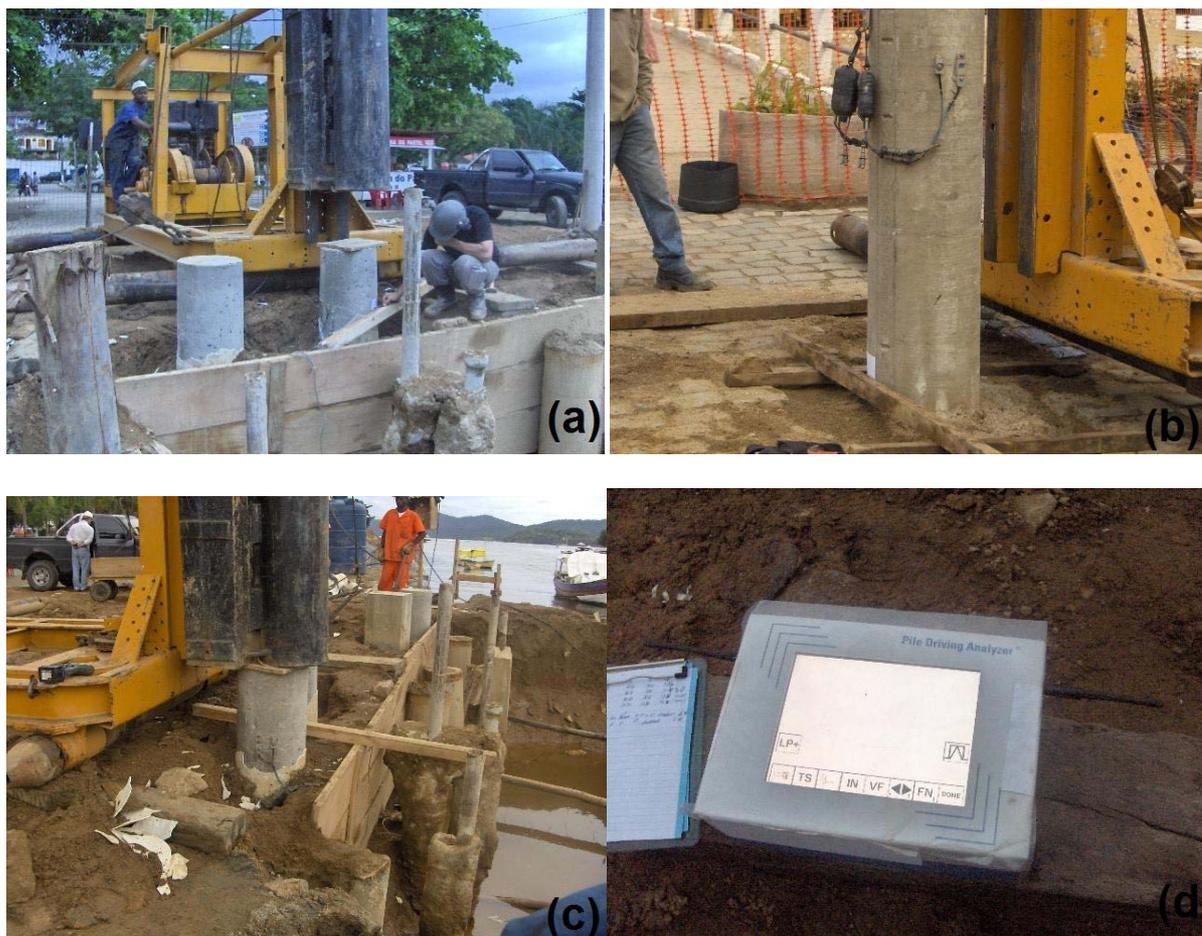
**Fotografia 28:** (a) sistema de amortecedor coxim de madeira, (b) sensores, (c) equipamento de cravação sobre esteiras (d) equipamento PDA modelo PAX.
