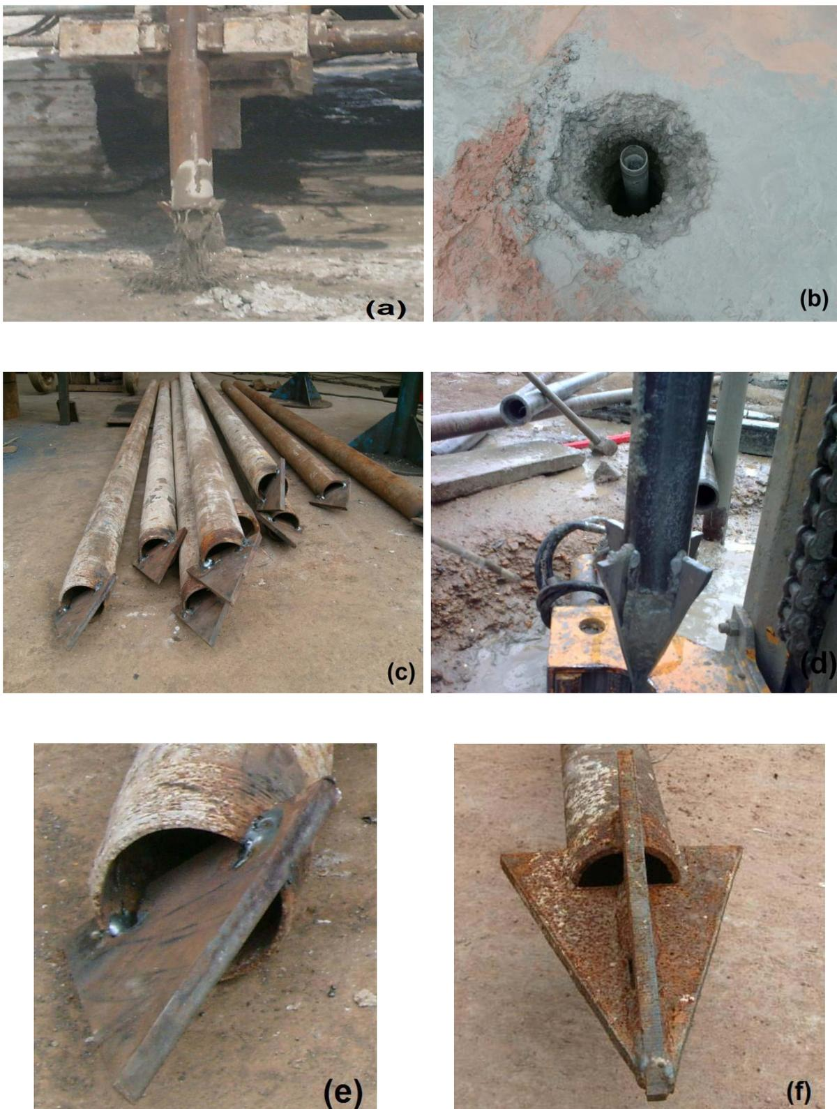
**Fotografia 11:** (a) detalhe da ponteira cortante com passagem para calda de cimento, (b) alargamento do fuste realizado pela ponteira, (c) ponteira em forma de seta para solos arenosos, (d) ponteira em forma de cruzeta para solos argilosos, (e) detalhe da passagem da calda para seta, (f) detalhe da passagem da calda para cruzeta.
