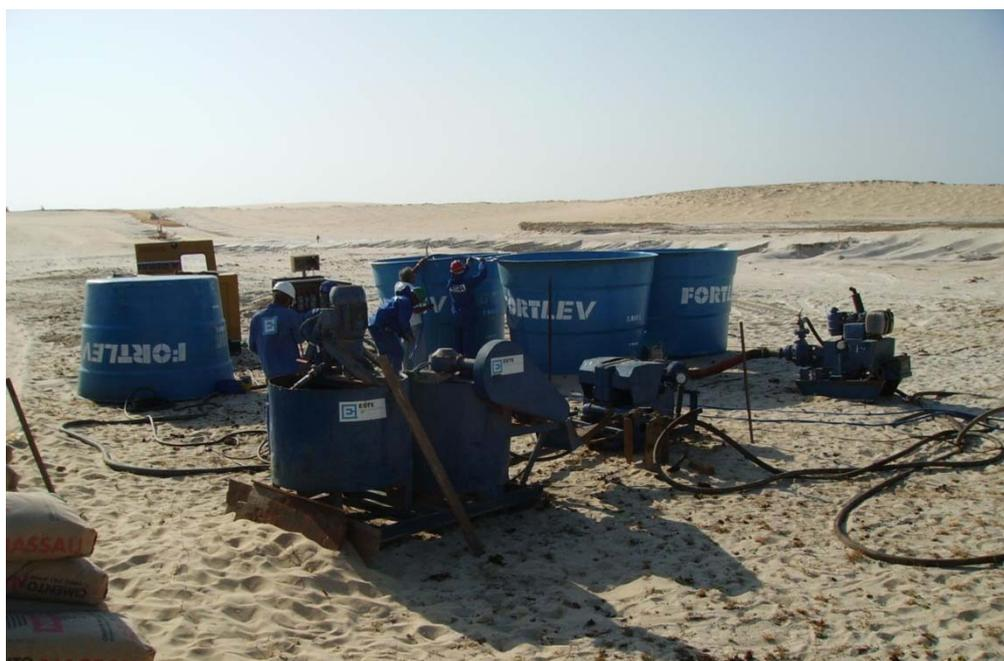
**Fotografia 12:** Equipamento de preparação e injeção da calda de cimento
