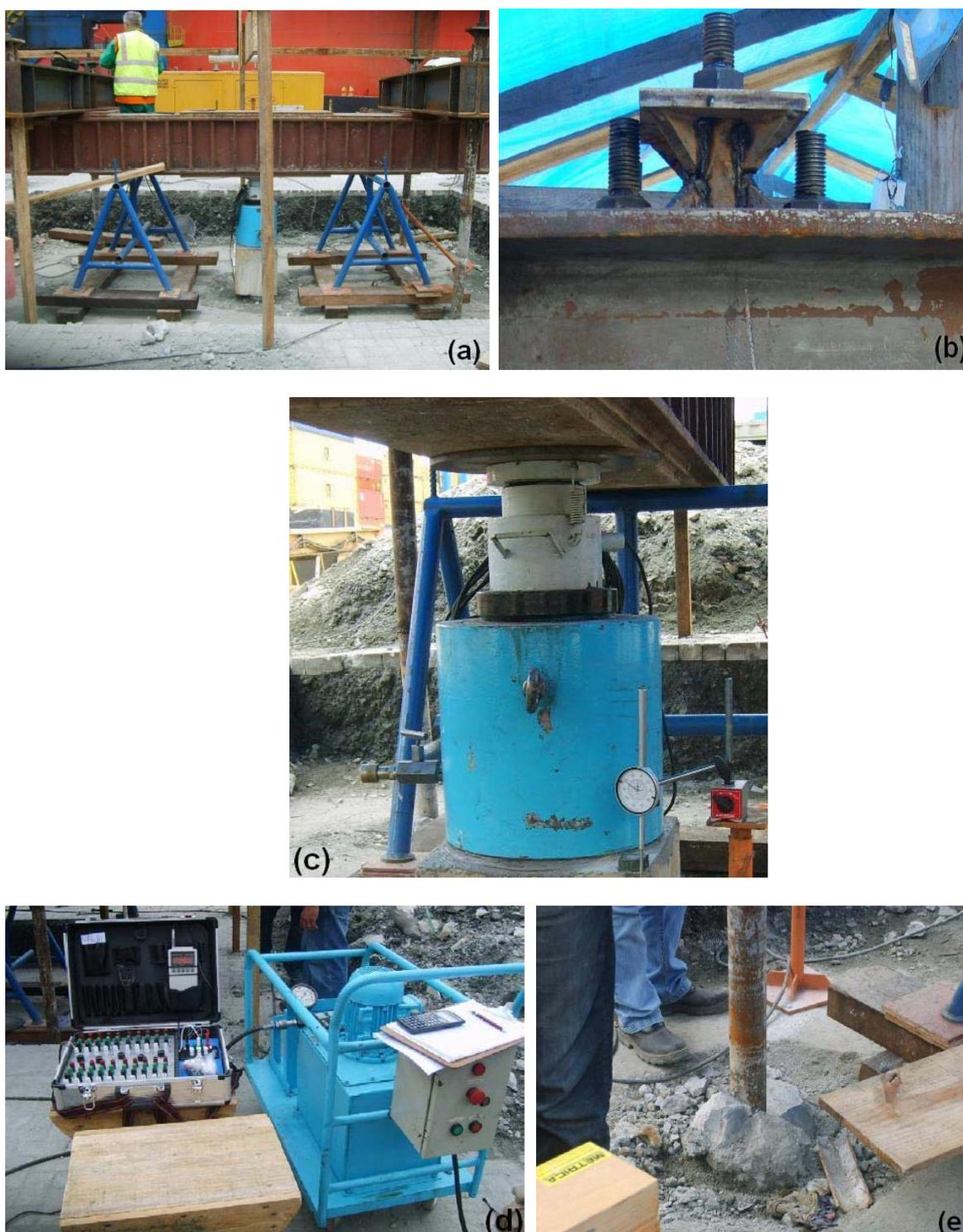
**Fotografia 24:** (a) sistema de reação, (b) detalhe do travamento entre o tubo da estaca e a viga de reação secundária, (c) macaco hidráulico, extensômetro e célula de carga, (d) painel de leitura da célula de carga e bomba hidráulica elétrica, (e) detalhe do topo da estaca e tubo metálico de arranque de 1,0m
