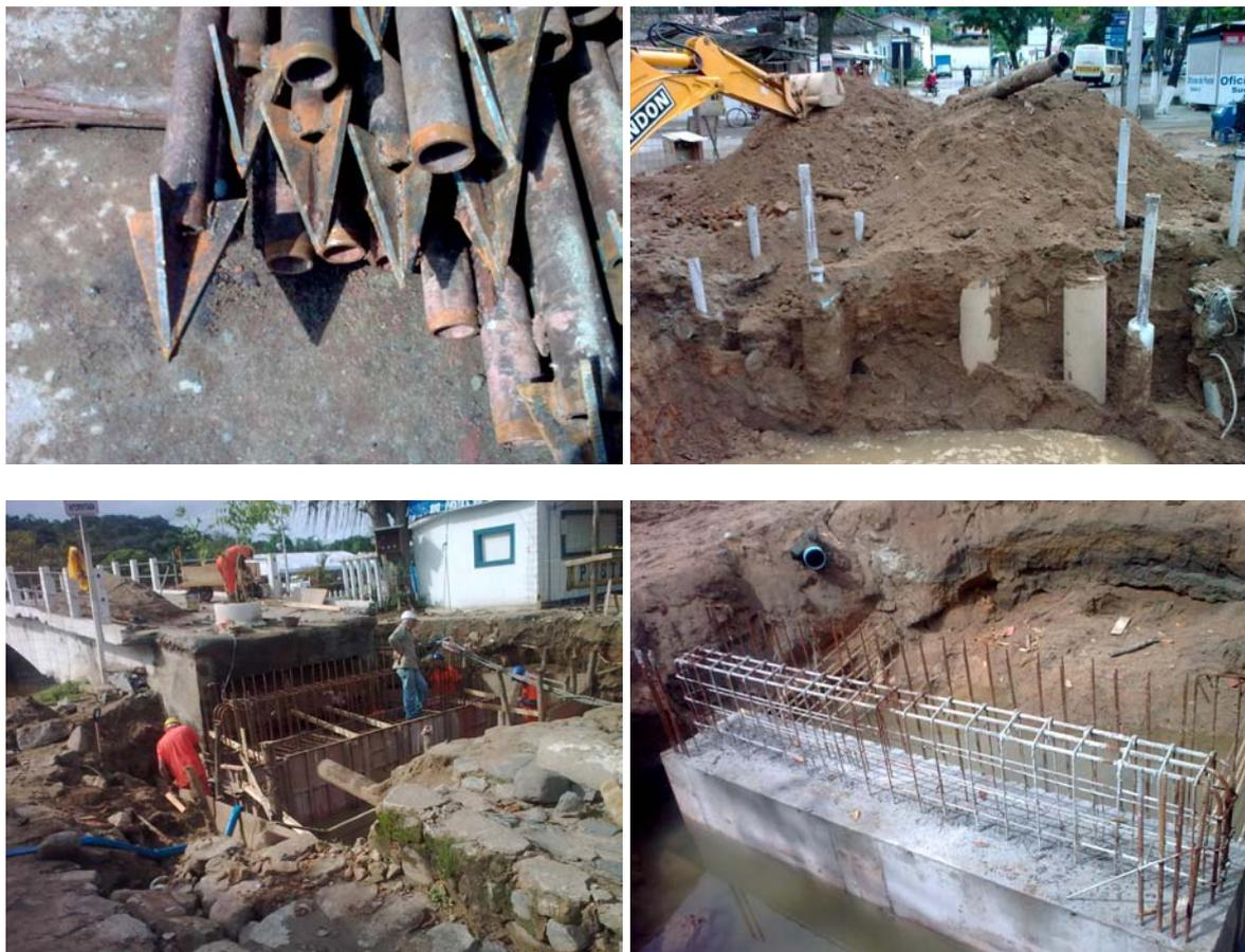
**Fotografia 26:** (a) ponteira para solos argilosos, (b) conjunto de estacas, (c) montagem bloco, (d) vigas transversais reforçadas por estacas injetadas autopercutantes.
