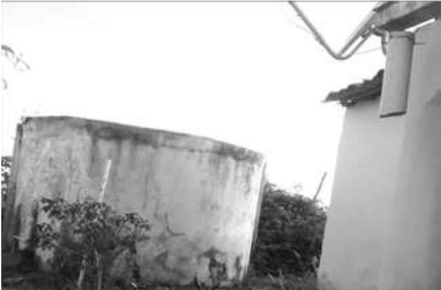
**Figura 5. Cisterna abastecida pela Operação Carro-Pipa, localizada no Sítio Angiquinho, sem a calha de coleta de águas da chuva**
