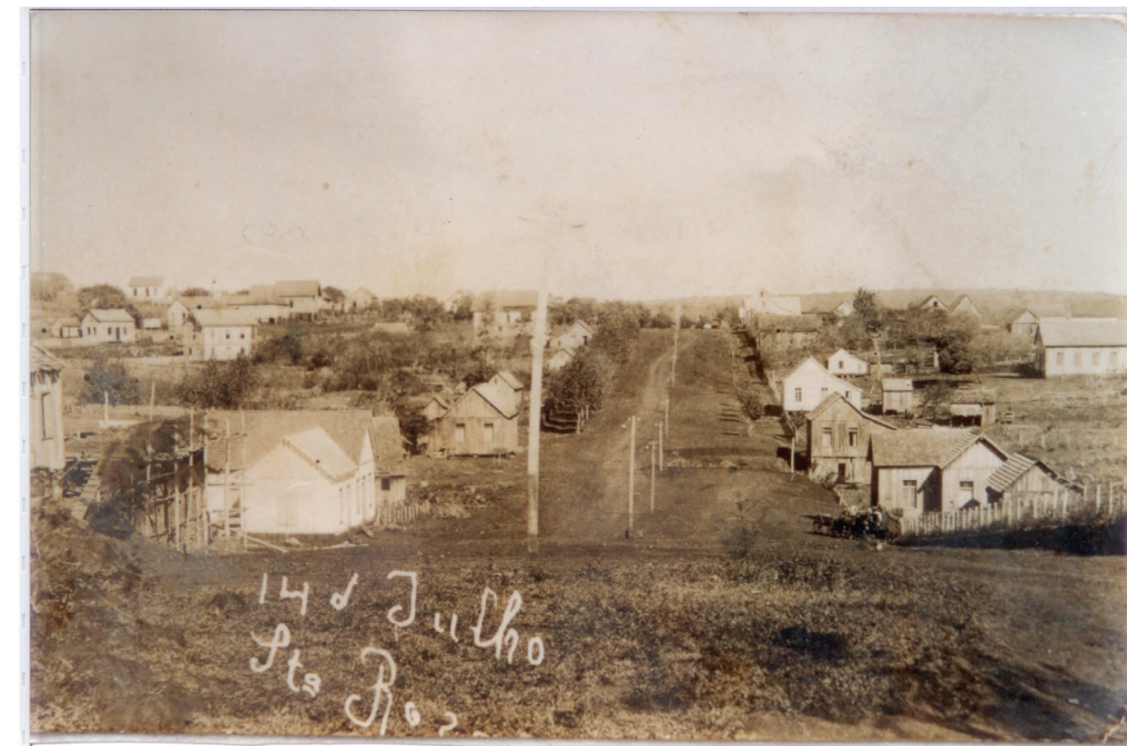
Figure 4: Construção da primeira casa em alvenaria.
