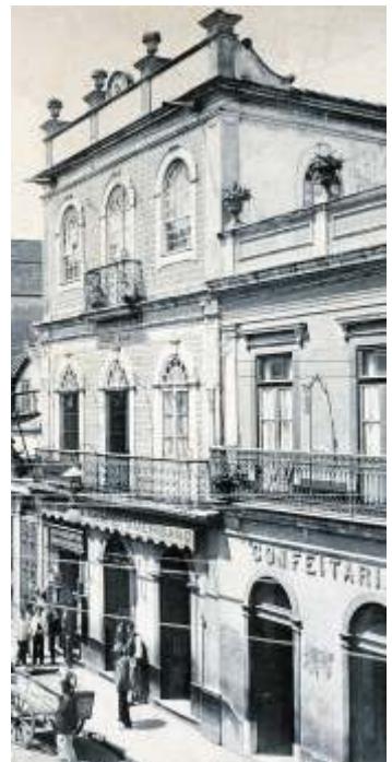
Sobrado à rua 15 de novembro, São Paulo. Fotografia de Guilherme Gaensly, cerca de 1900 (pormenor). Acervo do Museu Paulista USP.
