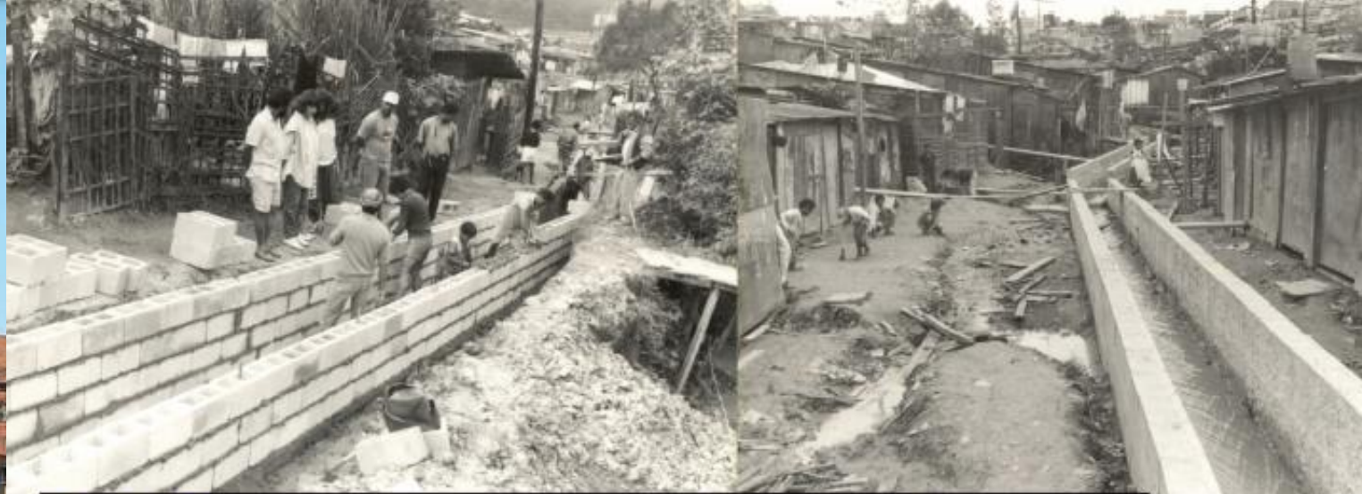
Figura 1.1 e 1.2. Realização de obras de drenagem por mutirão - União II - Diadema (déc. 1980) Fonte: PMD/SHDU.
