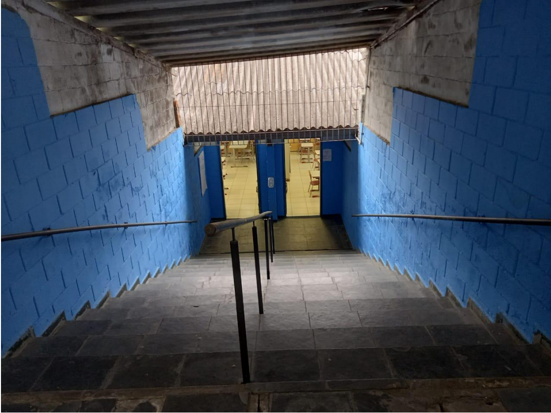
Acesso a duas salas de aula no subsolo
