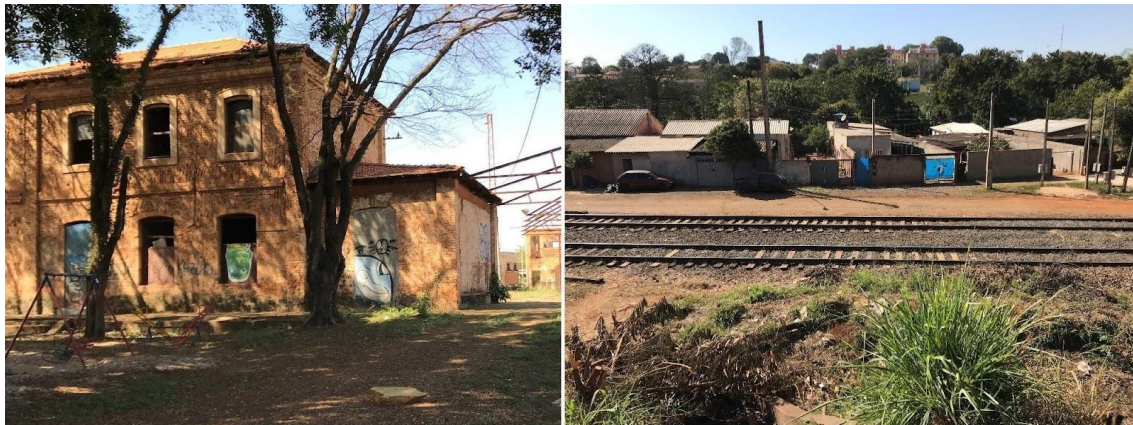
Figuras 4 e 5 - Levantamento de campo realizado no Pátio da Estação, Cordeirópolis– SP Fonte: PEXURB, 2021.
