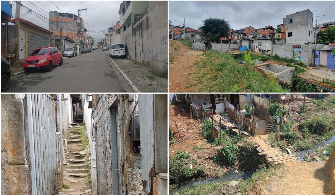
Figuras 6 a 9 - Levantamento de campo realizado na Comunidade Cachoeira das Garças, São Paulo– SP Fonte: PExURB, 2022.
