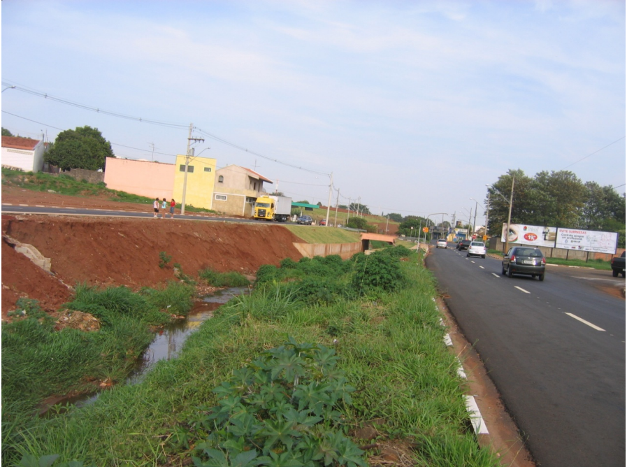
Fig 2. Ocupação de fundo de vale por avenida marginal (Foto: M. L. F. Nicodemo, 2008).
