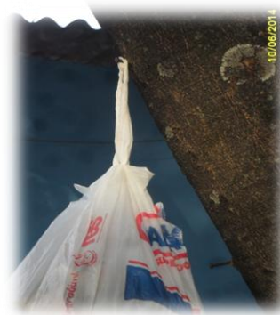
FIXAÇÃO DE PREGOS
