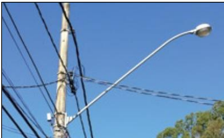
Figura 9 - Fiação elétrica isolada ou multiplexada
