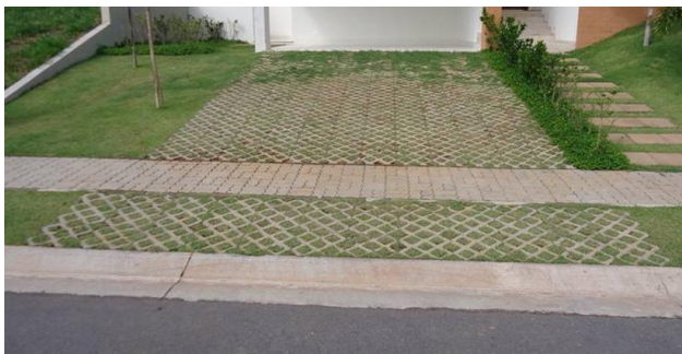
Figura 11 - Exemplo de concregrama utilizado na entrada de veículos.
