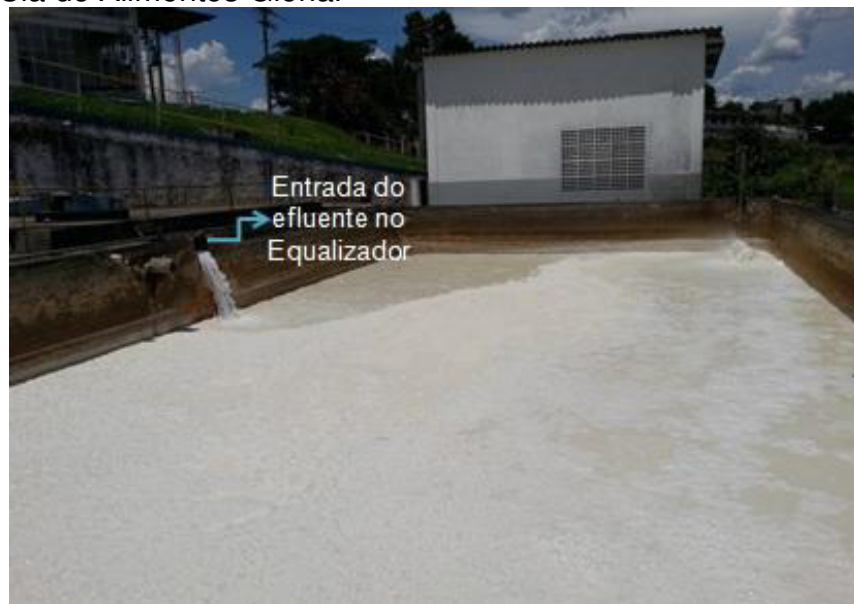
Figura 11 – Tanque de equalização da indústria de Laticínios Cia de Alimentos Glória.
