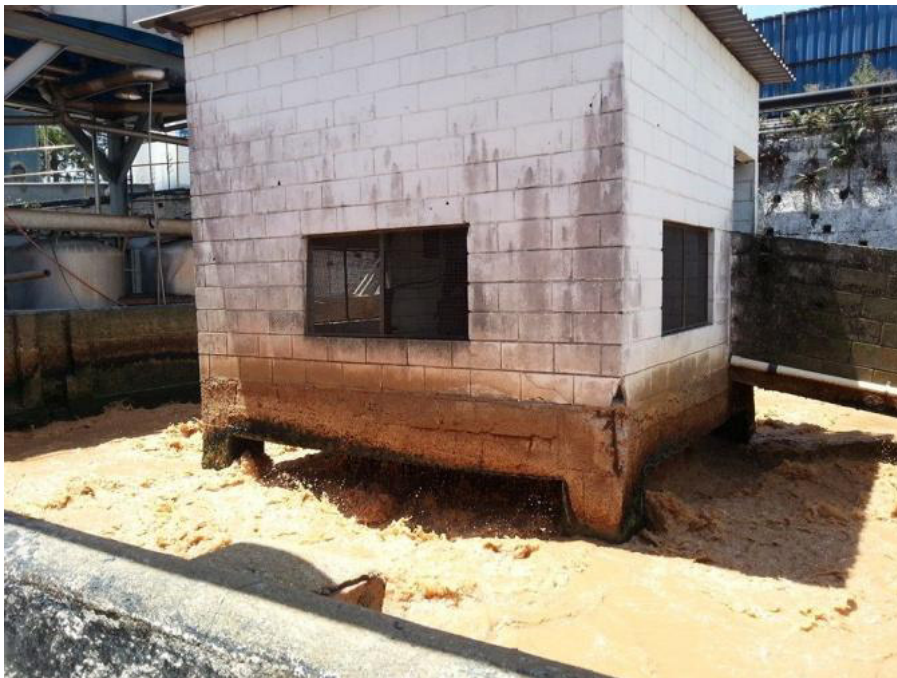
Figura 12 – Tanque de aeração da indústria de Laticínios Cia de Alimentos Glória.
