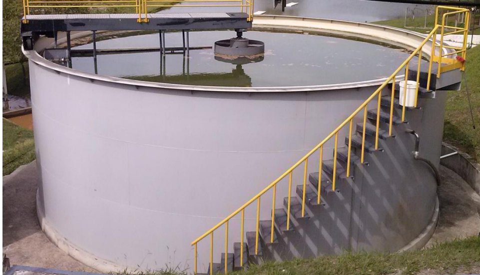
Figura 13 – Tanque secundário de decantação da indústria de Laticínios Cia de Alimentos Glória.
