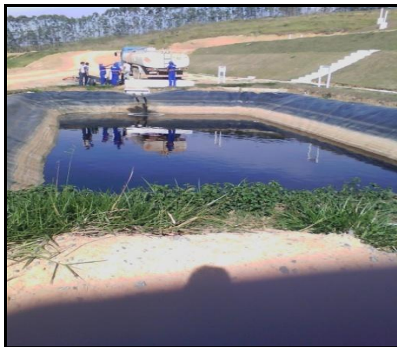
Figura 6 - Lagoa de chorume do aterro sanitário da cidade de Cachoeira Paulista-SP.
