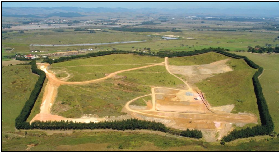
Figura 4 - Ilustração do entorno do Aterro Sanitário da cidade de Cachoeira Paulista-SP.
