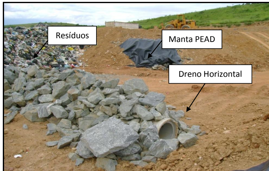
Figura 5 – Ilustração dos drenos horizontais do Aterro Sanitário.
