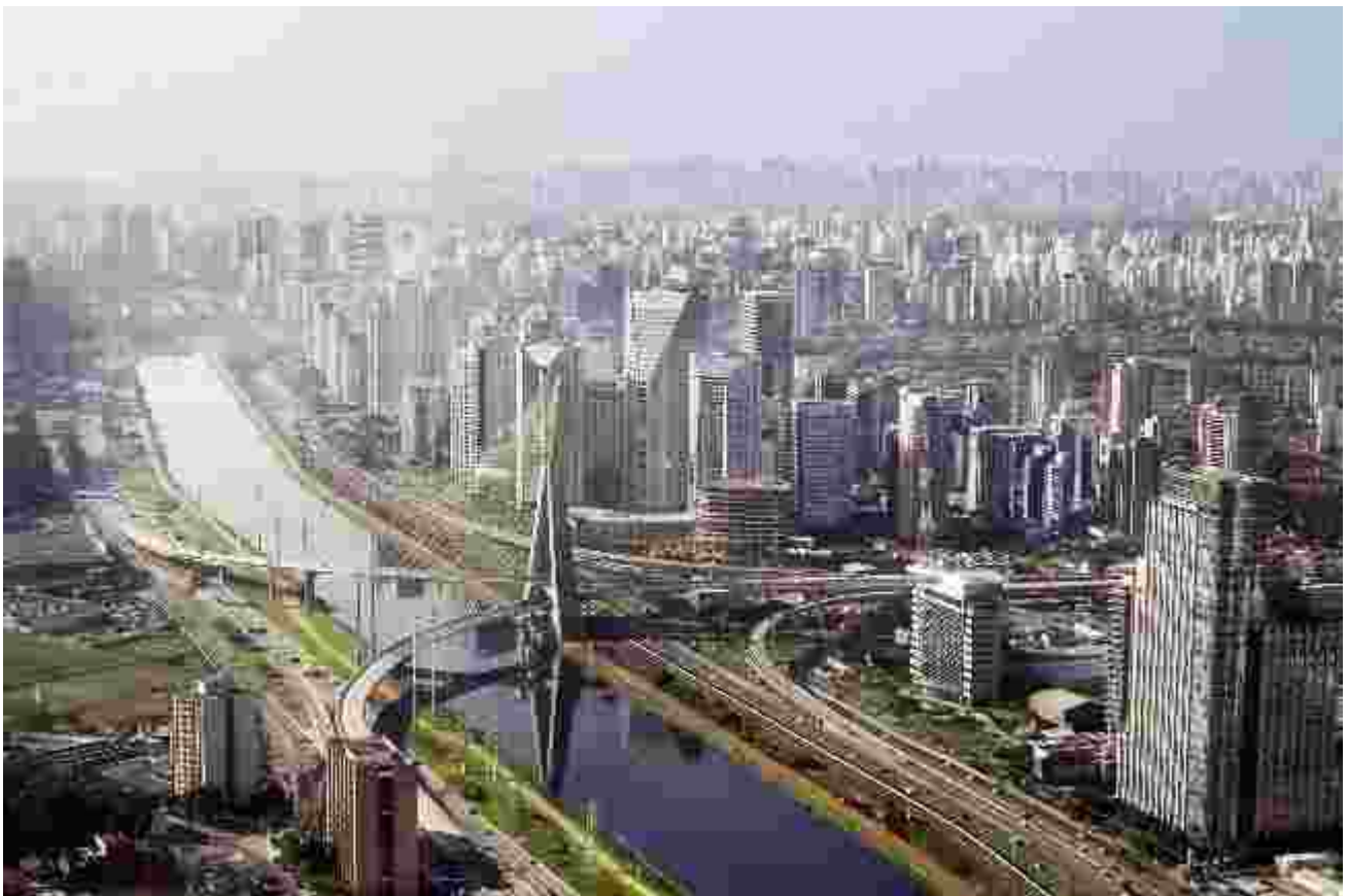
Figura 164: Ponte Estaiada em São Paulo. FONTE: (PIMENTA, 2012) in: http://www.turismo.gov.br/ultimas-noticias/3096-londres-2012--talentos-paulistas-na-terra-na-agua-e-no-ar.html
