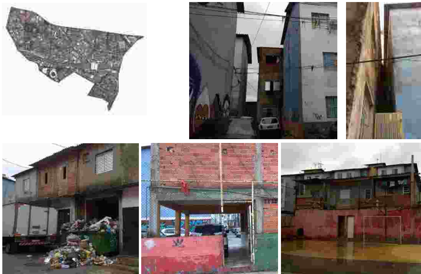
Figura 152: Localização da área de intervenção da Reforma Emergencial e imagens da execução da obra. Elaboração: NOGUEIRA, Laura A. a partir de informações contidas em apresentações do Grupo Gestor da OUCAB.
