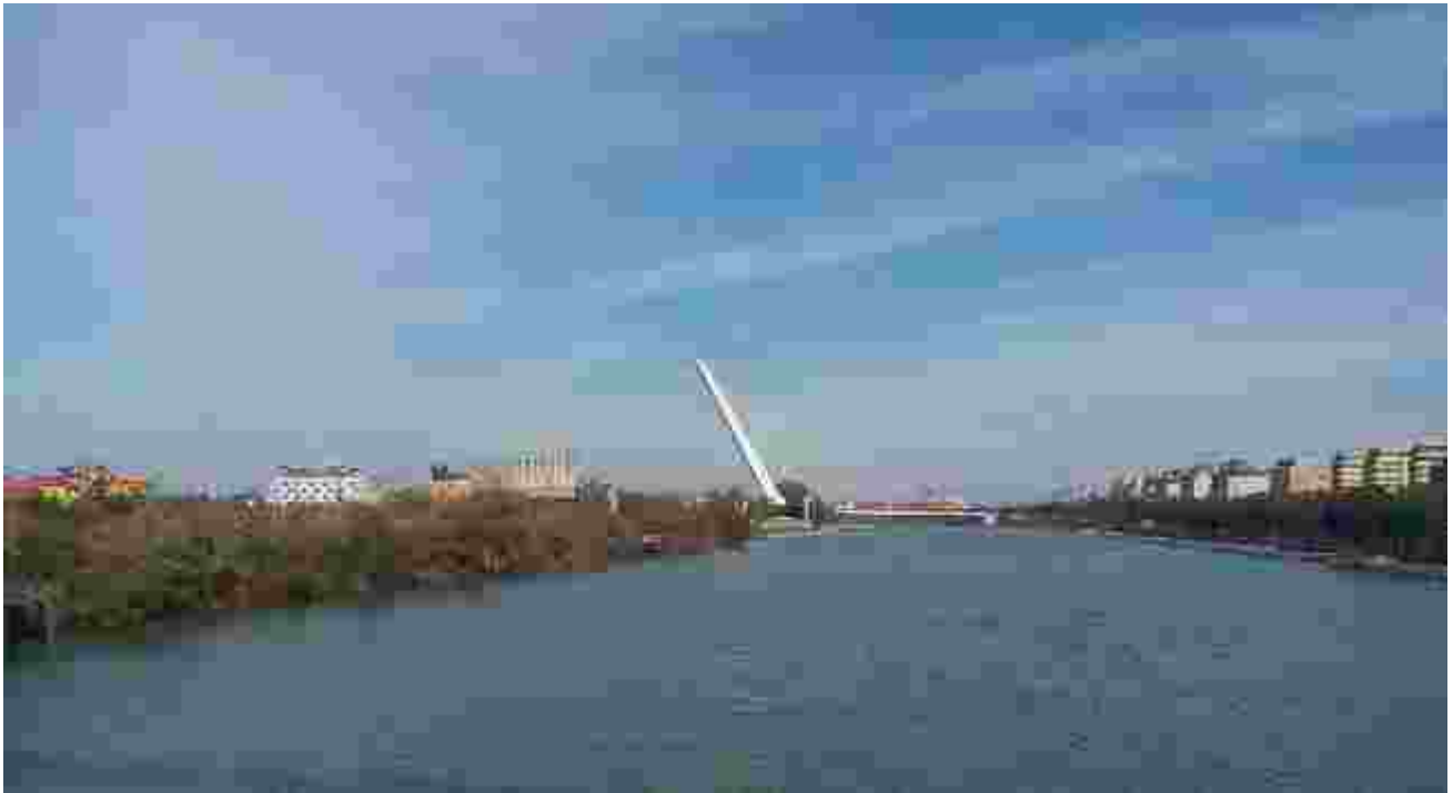
Figura 163: Ponte de Alamillo em Sevilha. FONTE: Acervo pessoal.
