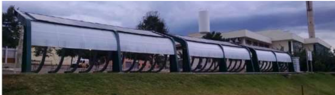
Figura 10. Ecobicicletário instalado próximo ao restaurante universitário
